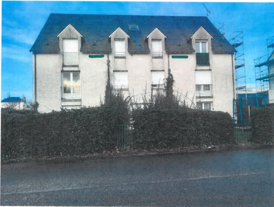
Bâtiment 3 : nids de moineaux
