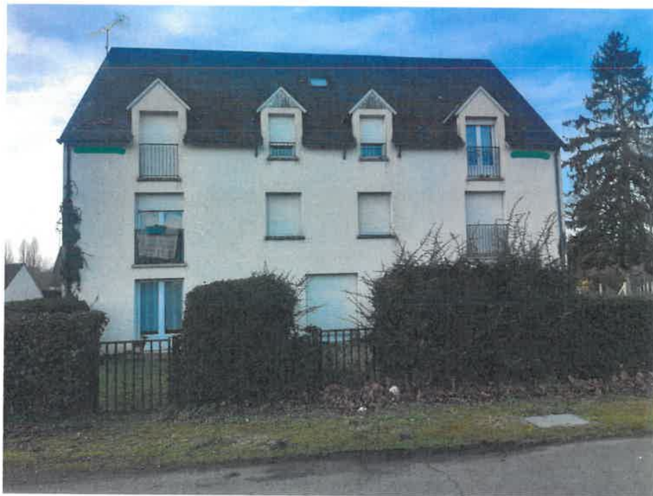
Bâtiment 2 : nids de moineaux
